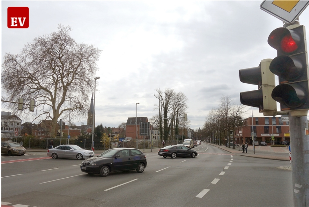
Die Kreuzung In der Lauge/Elbersstraße wird ab Mai zu einem Kreisverkehr umgebaut.
